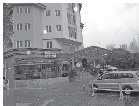
マレーシア・クアラルンプールの事務所が入居する建物の外観。右端に、街のシンボル、ツインタワーが見える
